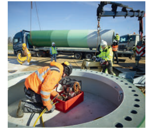
Anlieferung des Mastschaftes zum Mastfuß.
