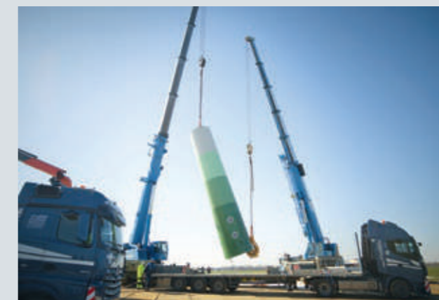
Kräne bringen ein Segment in senkrechte Position.
