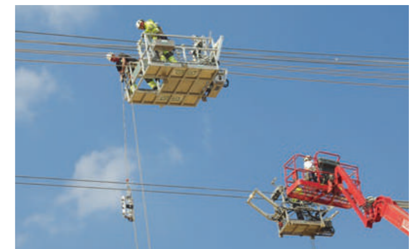
Die Rollenkästen werden durch Abstandshalter ersetzt.
