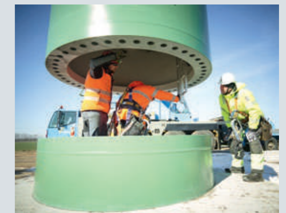
Ein Mastsegment wird aufgesetzt und verschraubt.
