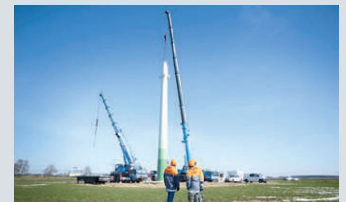
Der Mastkopf wird am Mastschaft angebracht.
