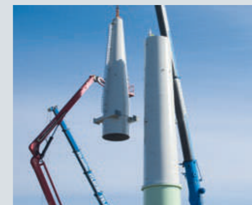
Aufsetzen des Mastkopfes eines Endmasts.
