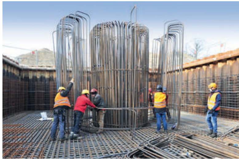
Auslegen der Stahlbewehrung für das Fundament eines Endmasts.
