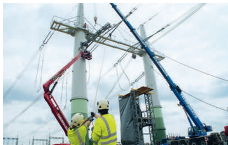
Spannen der Tragseile beschränkt das Ausschlagen.
