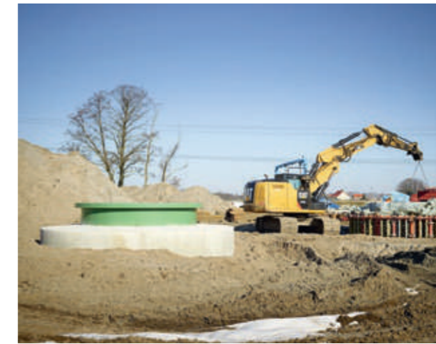
Die Fundamentkörper der zwei Endmast-Pylonen.
