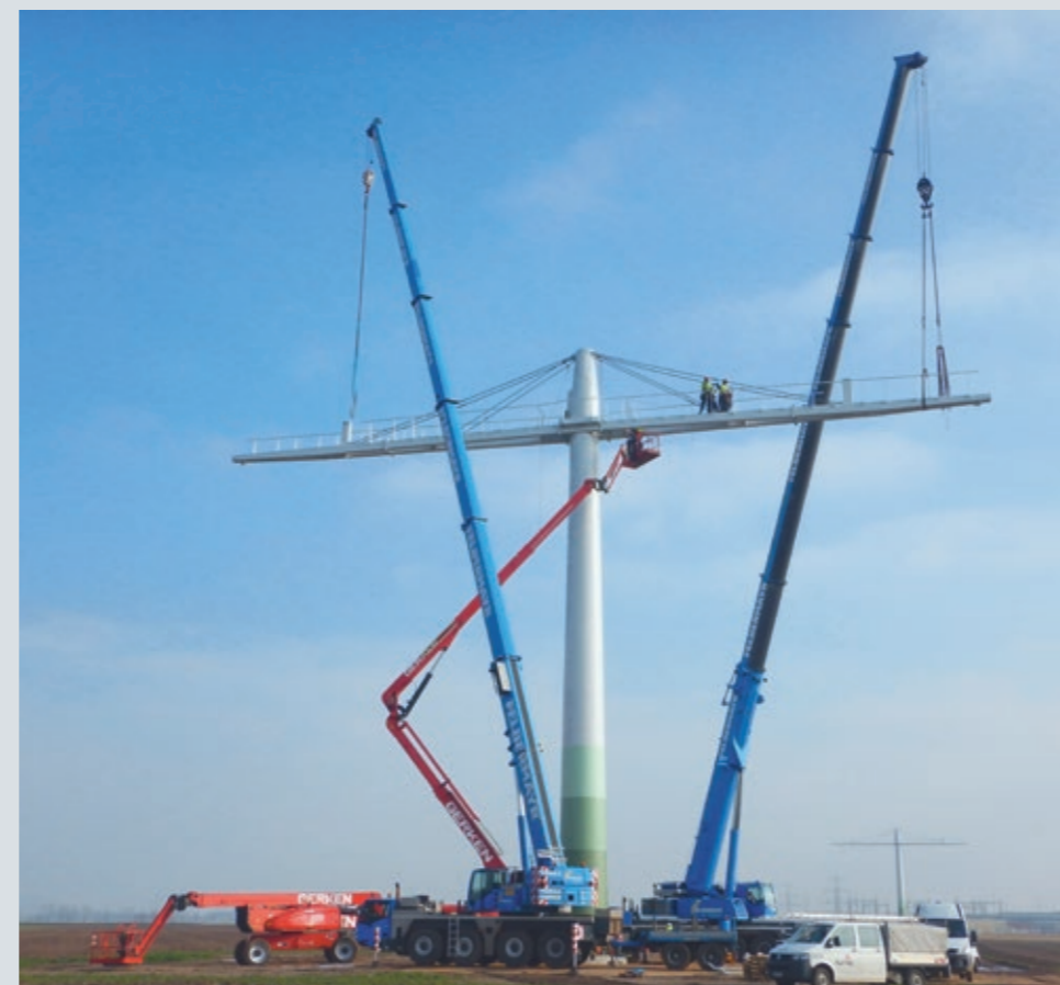
Anbringen der Traversen eines Tragmasts.
