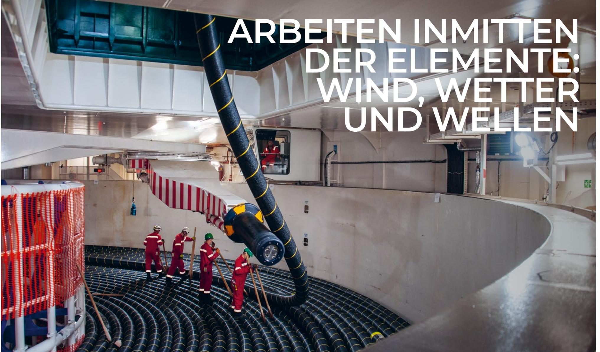
Beim Bau einer Offshore-Infrastruktur ist die Verlegung der Seekabel immer ein kritischer Moment. Die Herausforderungen bestehen darin, dass die Kabel empfindlich und schwer sind (bis zu 100 Kilogramm pro Meter) und dass das Personal auf gutes Wetter und ruhige Bedingungen auf See angewiesen ist.
