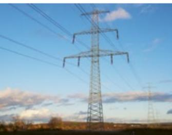
Bei dem Leitungsabschnitt zwischen Wolframshausen und Vieselbach (ca. 65 Kilometer) gibt es einen Donaumast. Hier werden die jeweils drei Leiter in Dreiecksform auf zwei Ebenen übereinander geführt. Dieser Leitungsabschnitt wurde 1988 gebaut. Die Masten sind zwischen 40 und 50 Meter hoch.
