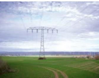
Bei dem Leitungsabschnitt zwischen Bad Lauchstädt und Wolframshausen (ca. 90 Kilometer) gibt es einen Einebenenmast. Hier werden die drei stromführenden Leiter auf einer Ebene angeordnet. Sie wurde 1965 errichtet. Die Masten sind ca. 25 Meter hoch.
